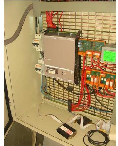
Automate de régulation – armoire électrique de la sous-station
