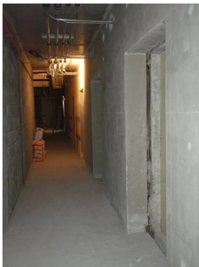
Figure 6 : Vue du couloir de bureaux – Coriolis (bureau testé : 3 e porte à droite)
