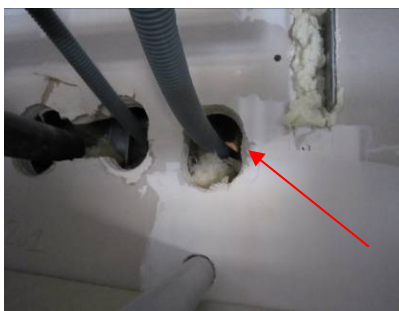
Figure 8 : ouverture visible entre le bureau informatique et le couloir - GH
